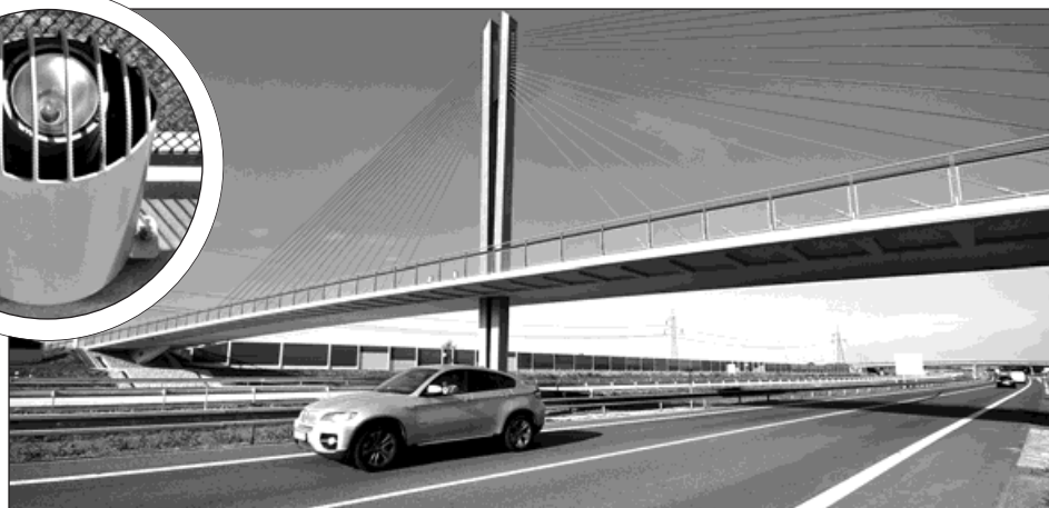
Lávka pro pěší a cyklisty vypadá majestátně, bohužel přitahuje problémy. Původní lampy někdo rozkradl. Nové reflektory proto chrání bytelné kryty. Foto: Pavel Čempěl
