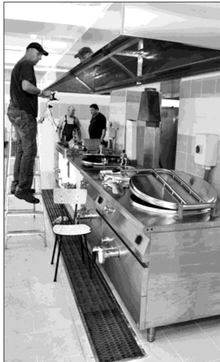
Generální oprava kuchyně ve škole Čs. armády. Poslední úpravy a může se zatopit pod kotlem.
