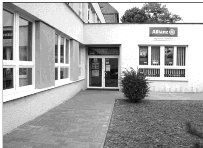
Před vstupem do knihovny je nový chodník a stojan na kola.
