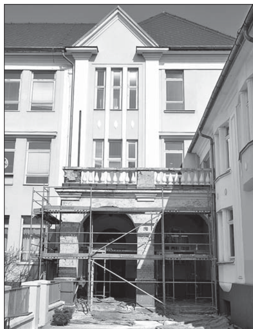
Škola pochází z roku 1924, ale některé části jsou o dvacet let mladší. V roce 1944 zasáhla školu letecká puma a zničenou budovu čekala nákladná rekonstrukce.
