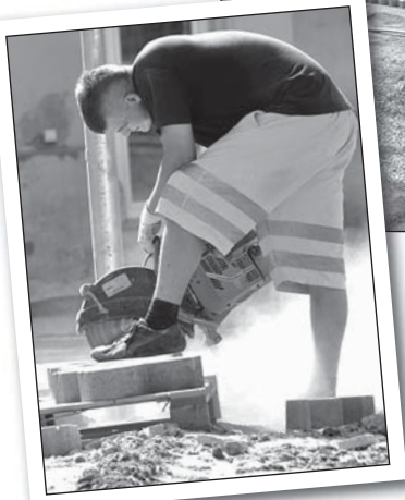
Na původním hliněném plácku vzniklo parkoviště ze zatravnovacích tvárnic. Stavbaři právě dokončili jednu polovinu dvora. Foto: Pavel Čempěl
