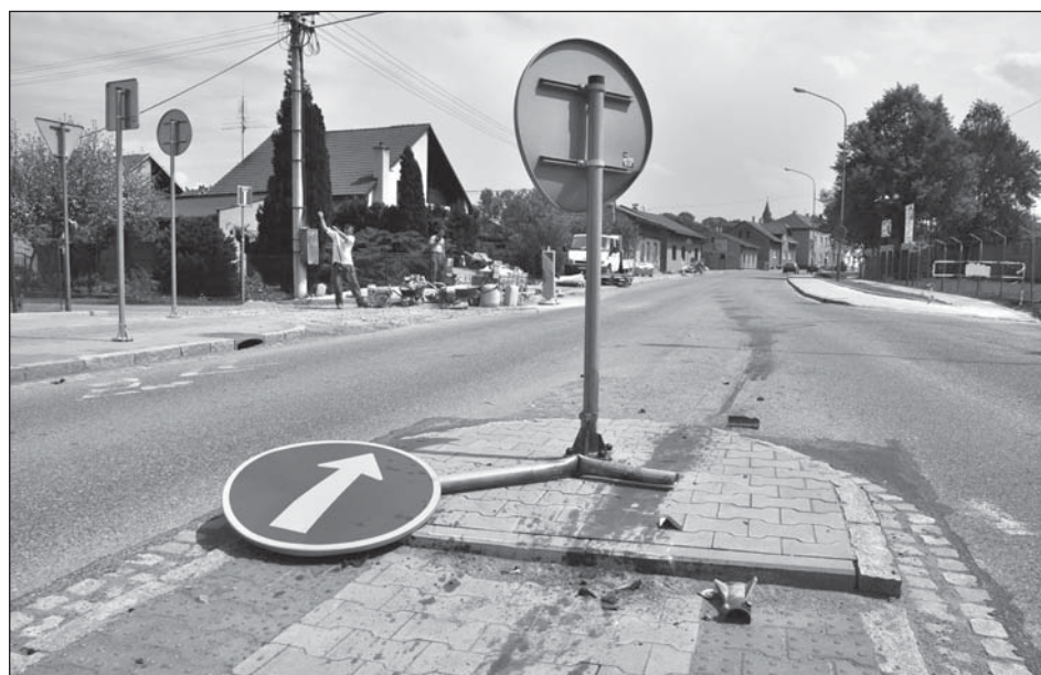
Řidiči si budou na novoty v ulici 1. máje chvíli zvykat. Některým dělají například problémy nové ostrůvky. Jeden nepozorný šofér už projel rovně a vzal s sebou i dopravní značení.
