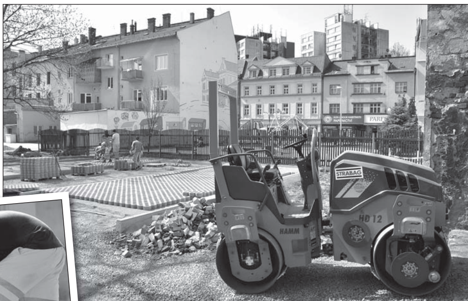
Na původním hliněném plácku vzniklo parkoviště ze zatravnovacích tvárnic. Stavbaři právě dokončili jednu polovinu dvora. Foto: Pavel Čempěl
