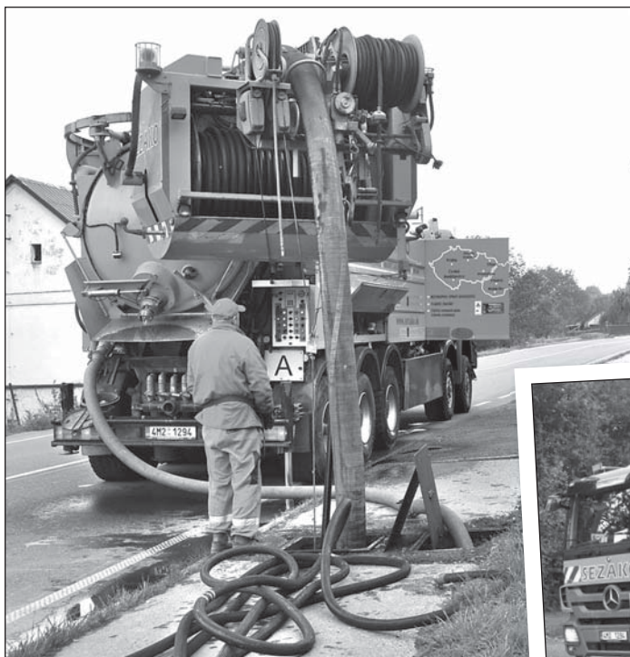
K čištění firma používá speciální vůz se sacím ramenem, které nečistoty nasaje i s vodou. Vodu následně v cisterně odstředí a vrátí zpět do potrubí. Foto: Pavel Čempěl
