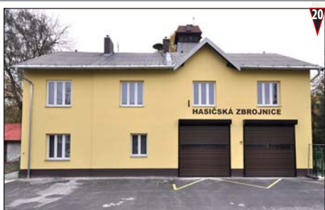
Oprava hasičské zbrojnice
