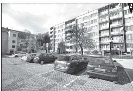
Vnitroblok za Grandem
