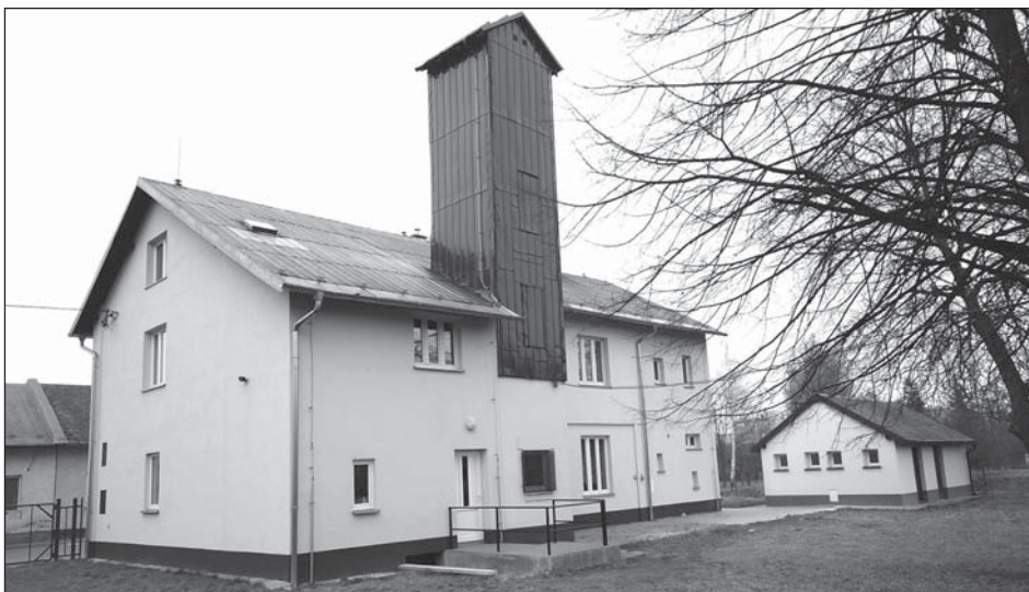
Oprava skřečonské hasičárny probíhala dva roky. Zbrojnice prošla kompletní obnovou a některé vybavení, například toalety a sprchy, má zcela nové. Foto: Pavel Čempěl
