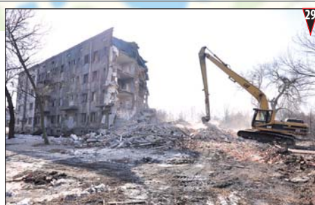
Demolice zdevastovaných domů
