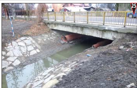
Odstranění odtokové závady
