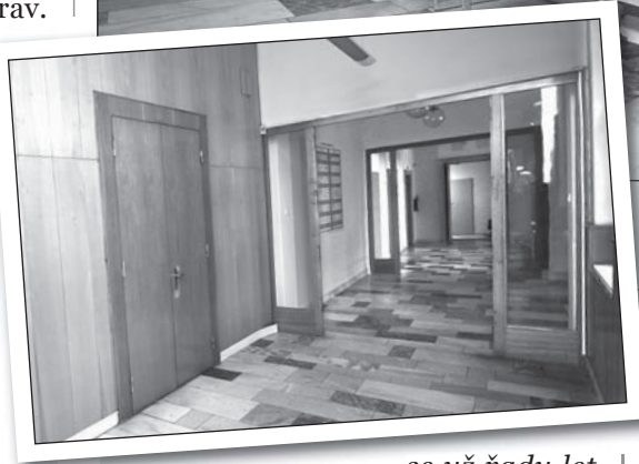
Překližkové kryty, obložky, sedáky, to vše musí pryč. Spolu s lítačkami stavbaři odstraní také vyzdívku nad nimi. Prostor se tak otevře.
