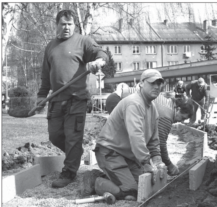
Na přelomu února a března se pracovníci BM servisu pustili do obnovy chodníku v Okružní poblíž bývalého hotelového domu.
