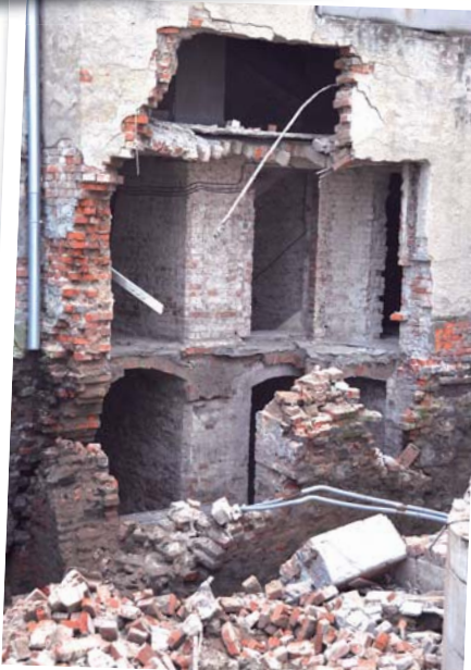
V zadním traktu, v místě, kudy vede hlavní schodiště do tanečního sálu, se zborčila část zdiva.
