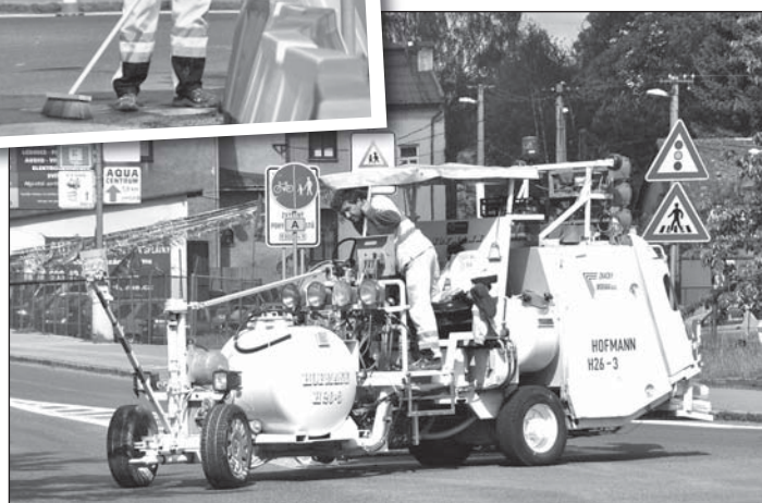
Obnova nástřiku vodorovného značení probíhala za plného provozu.
