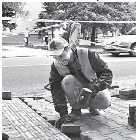
▲ Pokládka perforované dlažby pro nevidomé u Lidlu. ▲ V Lidické ulici vyrostl kromě přechodu i kus zbrusu nového chodníku. Foto: Pavel Čempěl
