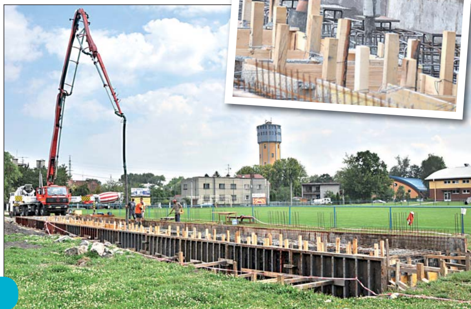
Betonování základů fotbalové tribuny pro 235 diváků. Foto: Pavel Čempěl
