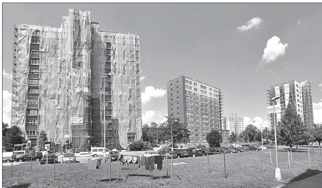
Věžové domy 1052, 1053 a 1054 v ulici Čs. armády se rekonstruují současně.
