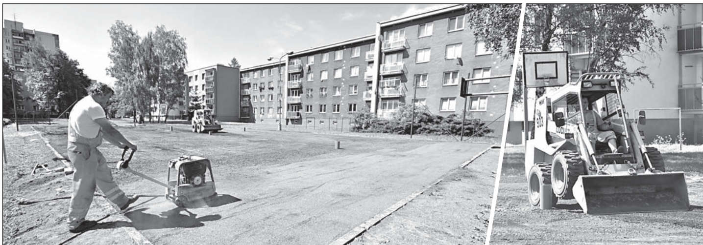
Povrch hřiště původně tvořil asfalt, který se ovšem po letech zdeformoval a popraskal. Nově bude mít hřiště povrch umělý.
