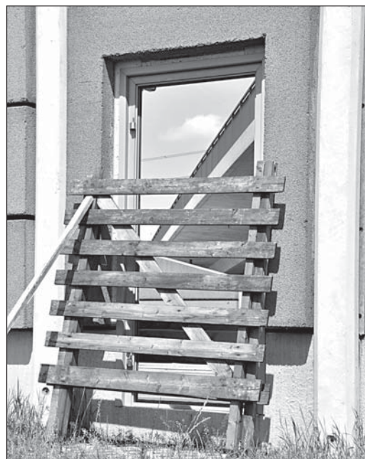
Otvory po dveřích jsou alespoň provizorně zabezpečené proti zvěři. Foto: Pavel Čempěl
