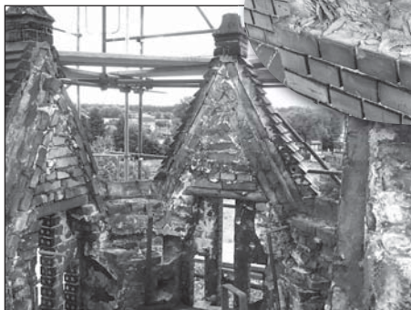
Narušené zdivo, ztrouchnivělé trámy a zrezivělý kříž s gumovou bání. S tím vším se museli řemeslníci vypořádat.
