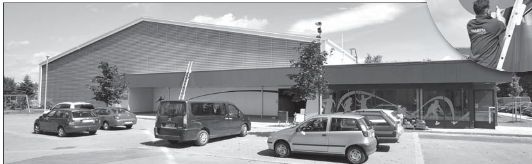
Sportovní hala těsně před dokončením. 20. srpna se na čelní fasádu instaloval zdáli viditelný nápis.
