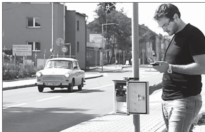
Ondřej Gogolín instaluje zařízení v ulici 1. máje. Přístroj zaznamenává rychlost vozidel, délku vozů (osobní, nákladní, motocykly) a rozestupy.
