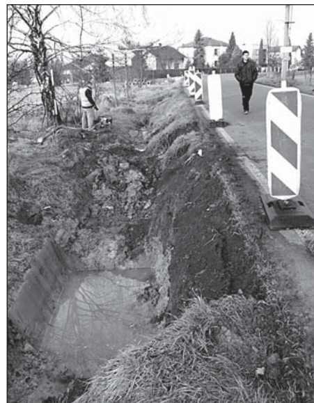
▲ Chodník vznikne v prostoru původního příkopu. Ten je nutné nejprve zatrubnit a zasypat. ◀ Nová komunikace pro pěší začíná u zastávky na rozcestí. Foto: Pavel Čempěl
