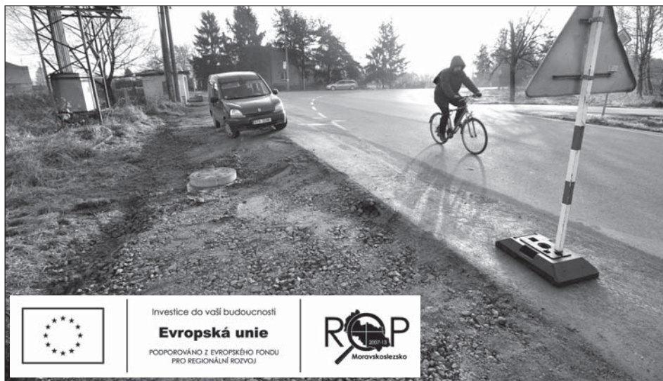
▲ Chodník vznikne v prostoru původního příkopu. Ten je nutné nejprve zatrubnit a zasypat. ◀ Nová komunikace pro pěší začíná u zastávky na rozcestí. Foto: Pavel Čempěl
