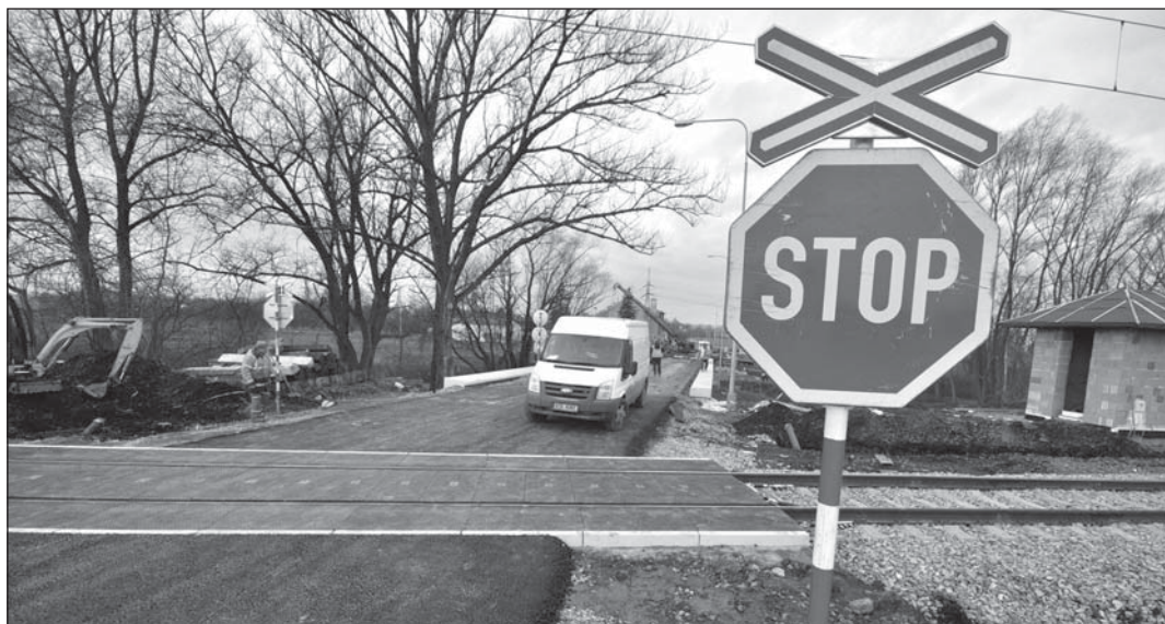
Na přejezdu finišují práce k jeho provizornímu otevření.
