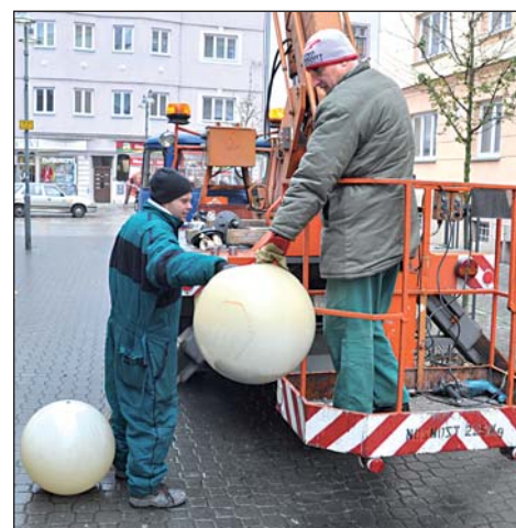
Staré kulaté lampy spotřebovaly hodně energie a zatékalo do nich. Foto: Pavel Čempěl
