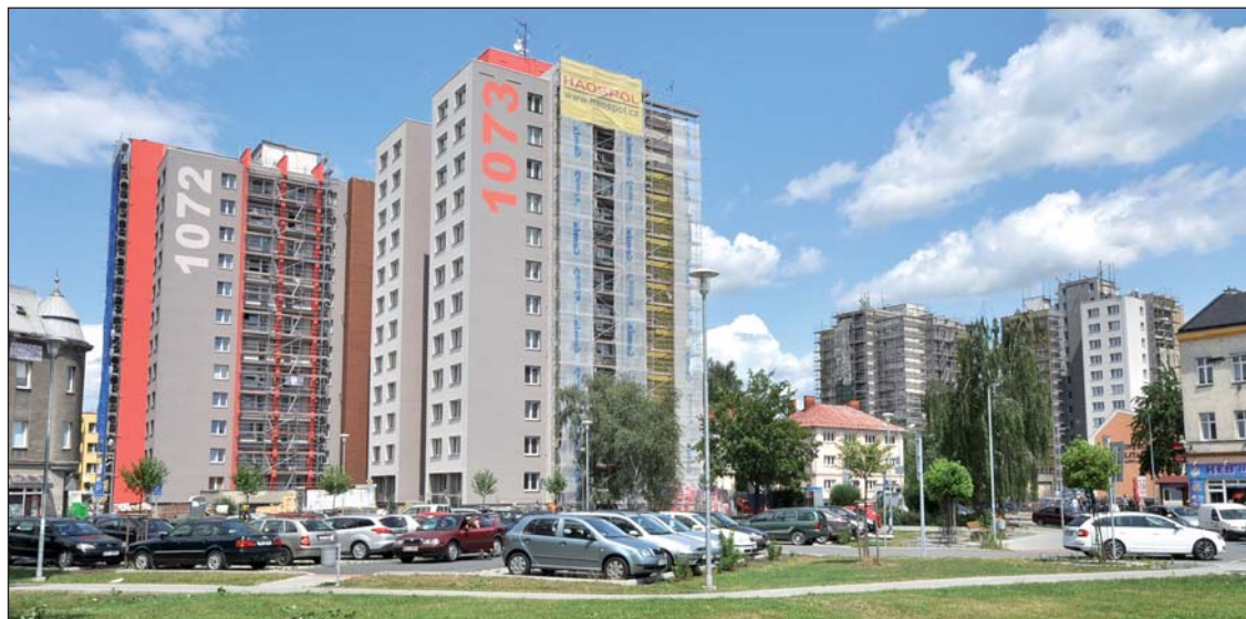
Věžáky čeká komplexní zateplení a dostanou i novou vizuální podobu. V případě domů u lokality Osvěta už je jasné patrná. Foto: Pavel Čempěl
