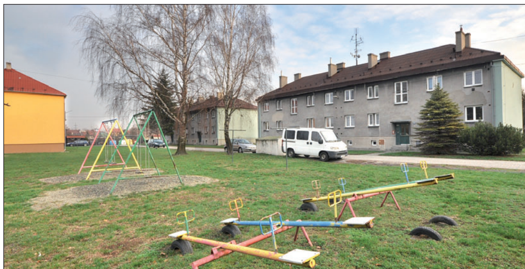
Obytné městské domy v Mládežnické a Dělnické ulici čeká v budoucnu napojování na dětmarovický teplovod.
