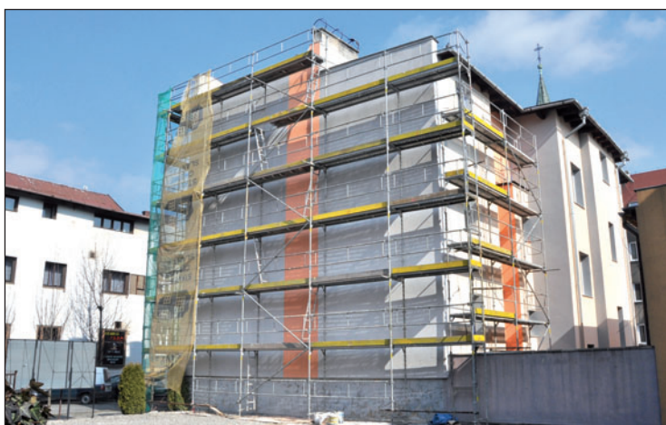
Dům v Kostelní ulici pochází z roku 1907. Boční stěny už jsou zateplené, čelní bude mít historickou podobu. Foto: Pavel Čempěl
