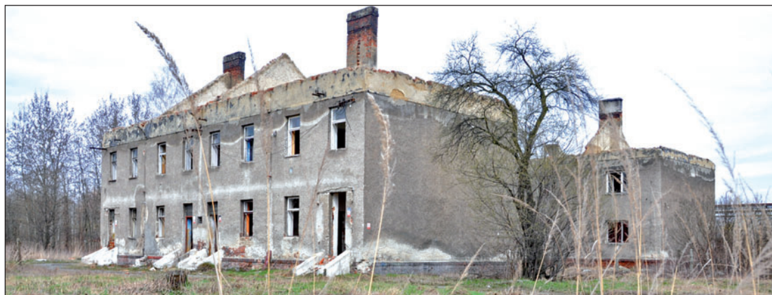
Bourat se letos bude v Revoluční ulici. Na demolici čekají tři vybydlené domy.
