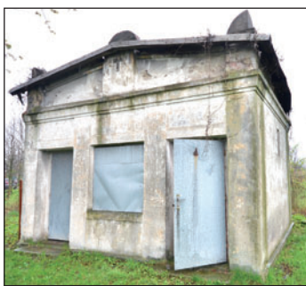
Zpustlá bývalá márnice ve Vrbici projde kompletní obnovou. Foto: Pavel Čempěl
