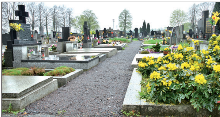
V bočních uličkách nahrazuje recyklát starý popraskaný asfalt.
