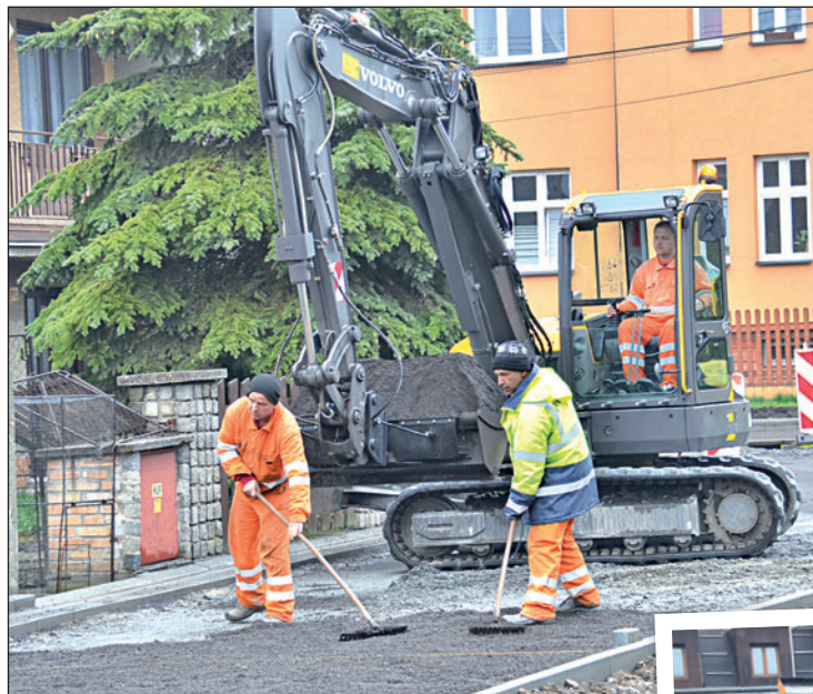
Ve starobohumínské Malé ulici už je kanalizace hotová. Posledním bodem byla oprava silnice, a to i v místech, kde se potrubí nepokládalo. Foto: Pavel Čempěl
