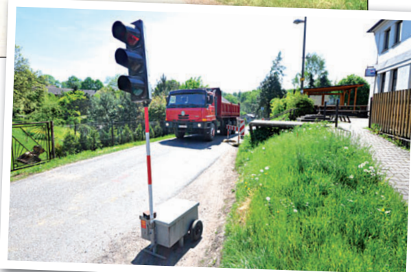
V záblatské ulici Na Pískách řídí provoz semafor. Začaly práce na rozšíření vozovky a vybudování chodníku.
