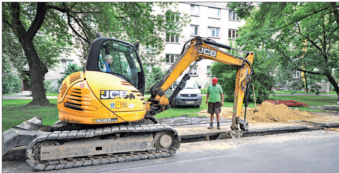
Oprava vodovodu v Šunychelské ulici si vyžádala dílčí dopravní omezení.
