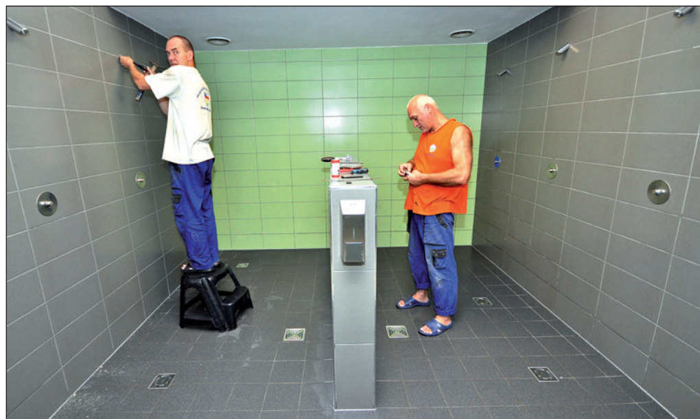
Nové prostředí sprch u bazénu. Jsou zde jiné obklady a přibýla dělicí příčka.
