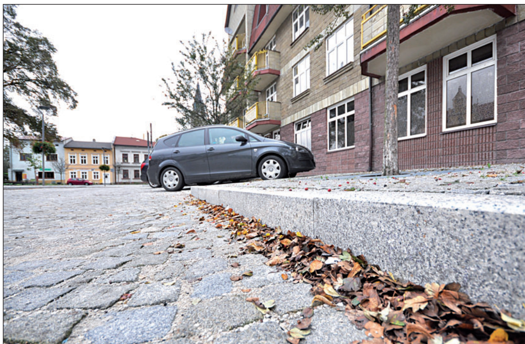
Obrubníky na náměstí Svobody komplikují invalidům vystupování z vozidel.
