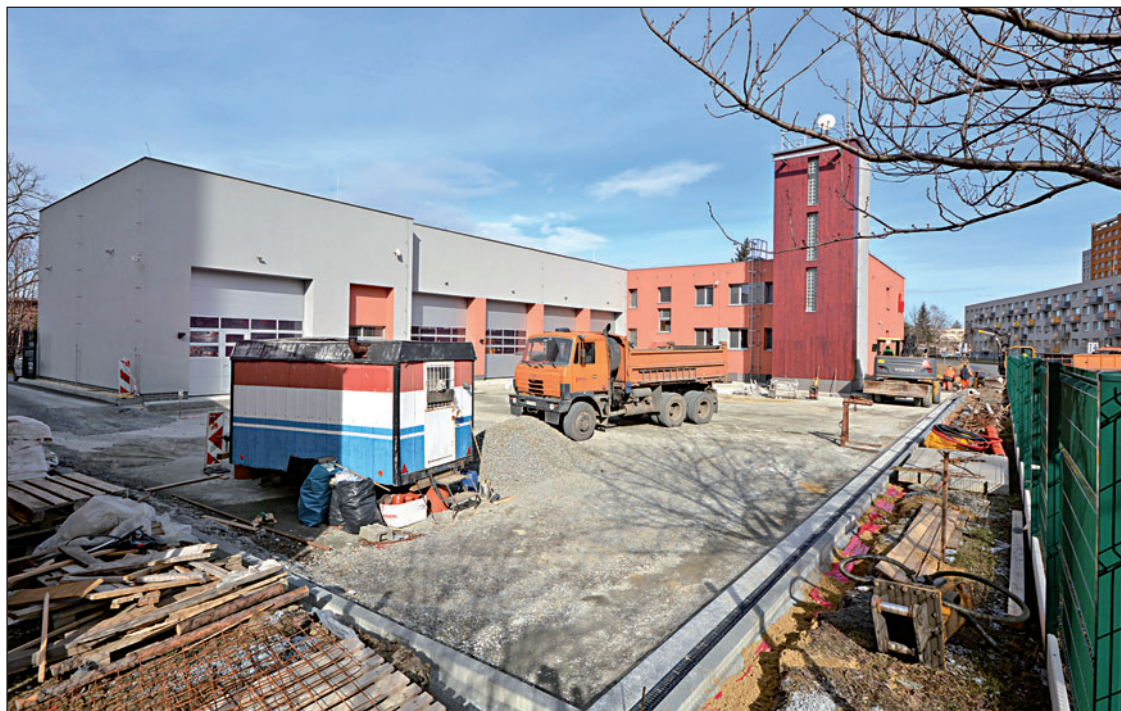
Správní budova, věž i garáže prošly modernizací v uplynulých letech. Nyní došlo na úpravu dvora stanice profesionálních hasičů. Foto: Pavel Čempěl
