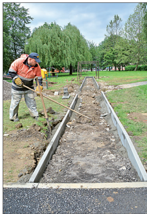
U věžáků mezi Bezručovou a Revoluční ulicí vznikají nové chodníky ze zámkové dlažby.
