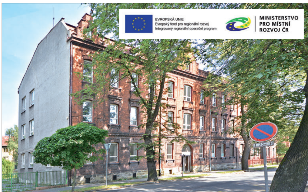
Stavby z červených neomítaných cihel byly na počátku minulého století v kurzu. Ovšem budova po necitlivých úpravách a nahození brizolitové omítky o původní vzhled přišla. Foto: Pavel Čempěl
