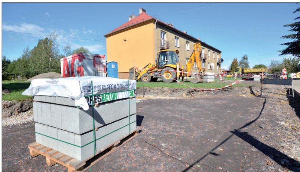
Napojování na horkovod v Mládežnické a Dělnické ulici skončilo, nyní se stavbaři vrhli na úpravu veřejných prostranství. Foto: Pavel Čempěl
