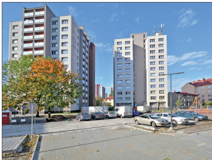
Přestavba pamatovala i na řidiče. Ti se nových míst nemohli dočkat a parkovali na nich ještě před dokončením stavby.
