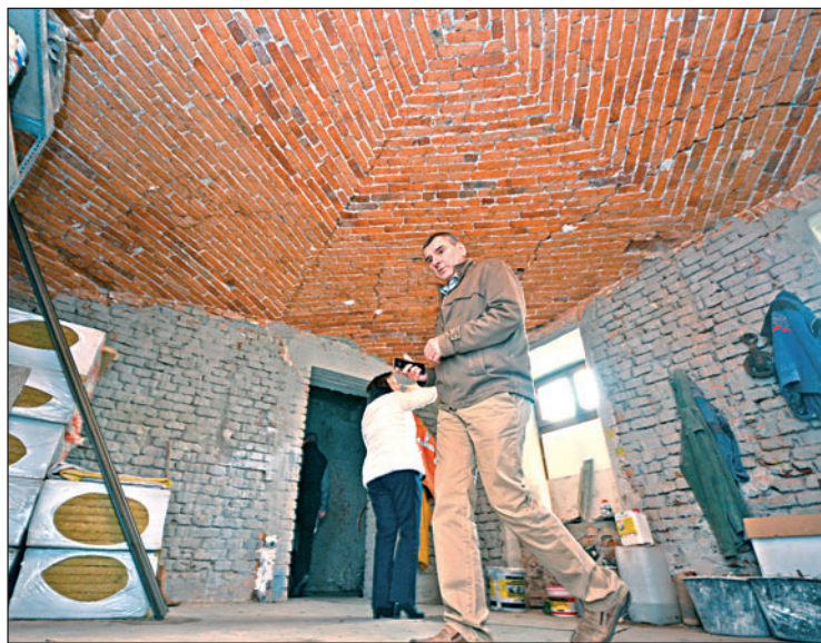
Zástupci radnice si prohlédli interiér budovy, ve kterém stojí za pozornost třeba původní klenuté stropy. Foto: Pavel Čempěl
