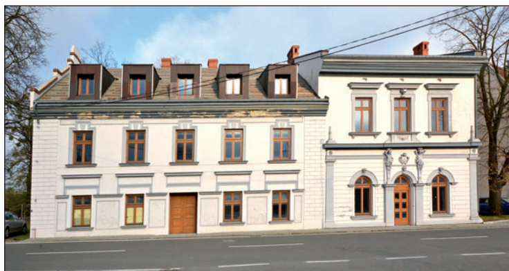
Bývalá myslivna, respektive hotel Scholtz, pochází z 19. století. Rekonstrukce vrátila fasádě historickou podobu, ale po zastavení prací objekt opět chátrá.
