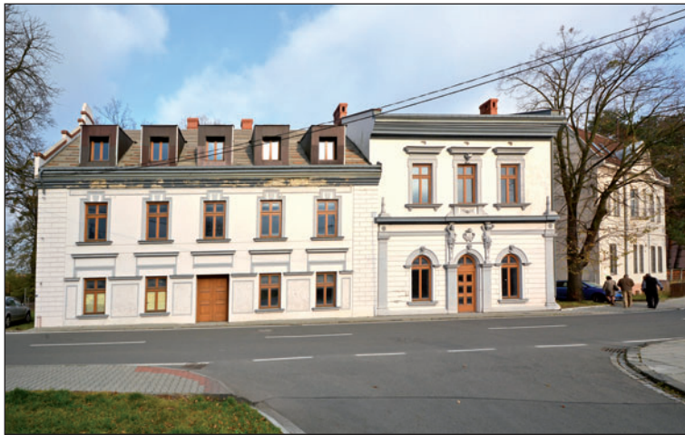
V myslivně v současnosti probíhá sanace klenutých stropů, v březnu chce nový majitel objekt zastřešit. Foto Pavel Čempěl
