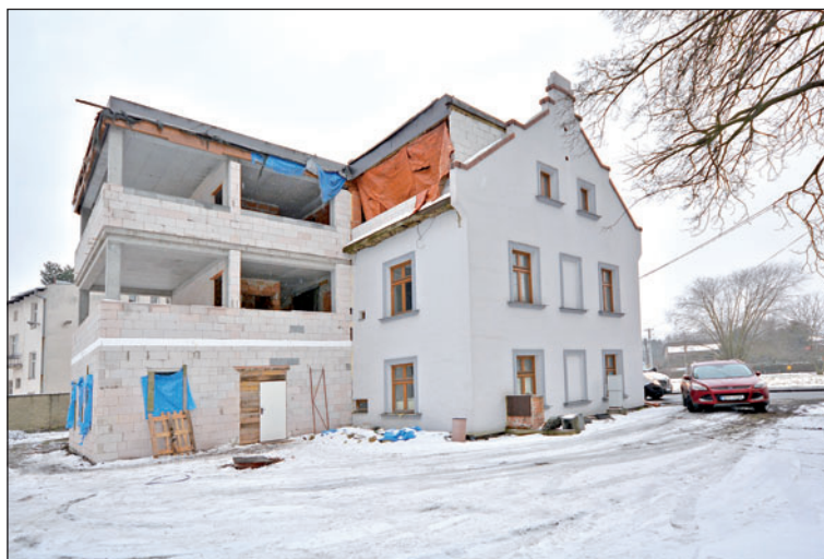
Využití najde i moderní betonový skelet v zadním traktu. Už se zde opět pracuje.
