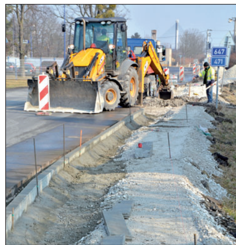
▲ Pod krajnicí stávající vozovky narazili stavbaři na tři vrstvy asfaltu z minulého století. ◀ Nový chodník na křižovatce ulic Čs. armády a Ostravské zajistí větší bezpečnost pěších. Foto: Pavel Čempěl
