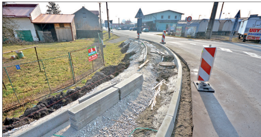
▲ Pod krajnicí stávající vozovky narazili stavbaři na tři vrstvy asfaltu z minulého století. ◀ Nový chodník na křižovatce ulic Čs. armády a Ostravské zajistí větší bezpečnost pěších. Foto: Pavel Čempěl
