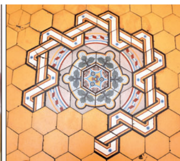
Součástí historické dlažby jsou i složité ornamenty. Radnice nechala vyrobit repliky jednotlivých vzorů a poškozené či chybějící kusy postupně nahradí. Foto: Pavel Čempěl
