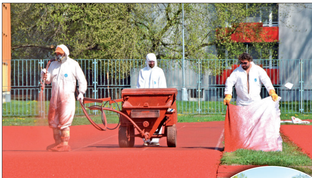
Jako v »laboratoři«. Ochranné pomůcky a prostředky jsou při nástřiku umělého povrchu nezbytné.
