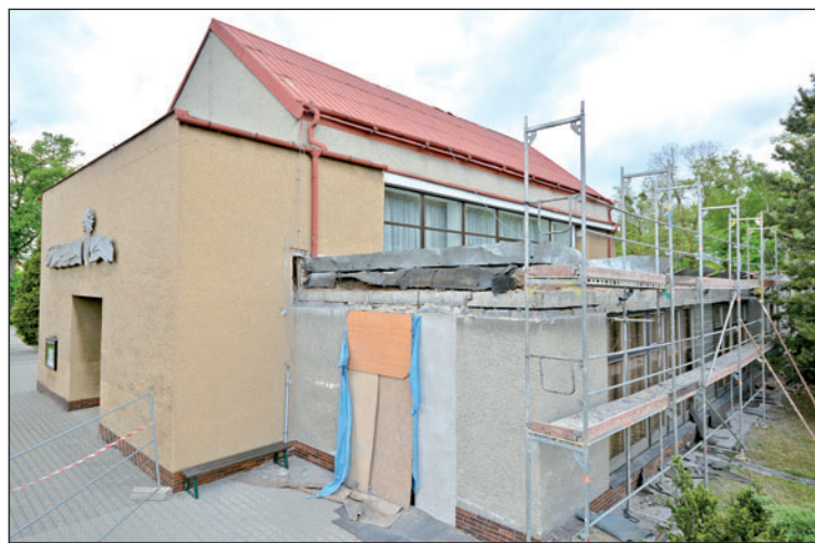
Obřadní síň už měla nejlepší léta za sebou a nutně potřebovala rekonstrukci exteriéru. V příštích letech by se inovace měly dotknout také vnitřních prostor.
