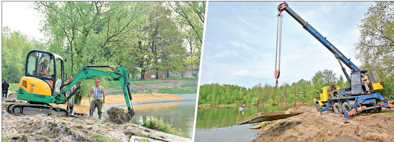
Některé betonové panely ujížděly, byly příliš strmé a přístup z nich k vodě krkolomný. Město je nechalo srovnat, dosypat a okolí upravit. Foto: Pavel Čempěl
