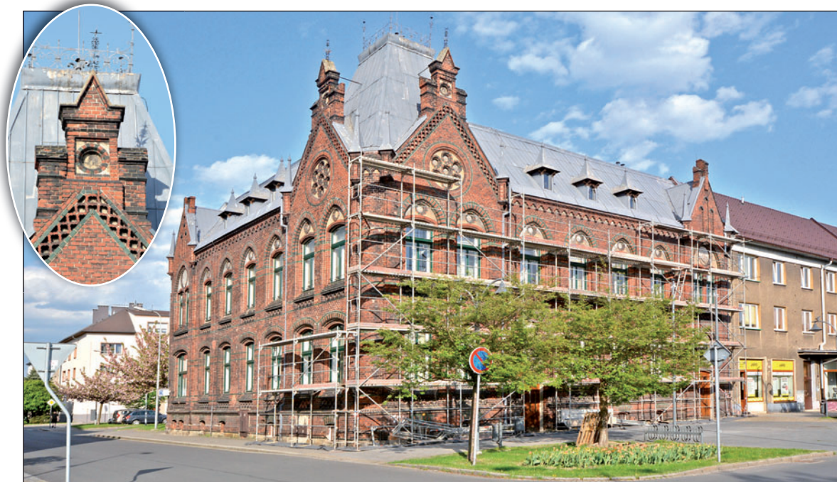
Historická radniční budova prochází očištěnou a renovací fasády. Nově už se před ní tyčí dva vlajkové stožáry a na čelní straně přibude pamětní deska s připomínkou návštěvy T. G. Masaryka v Bohumíně. Foto: Pavel Čempěl
