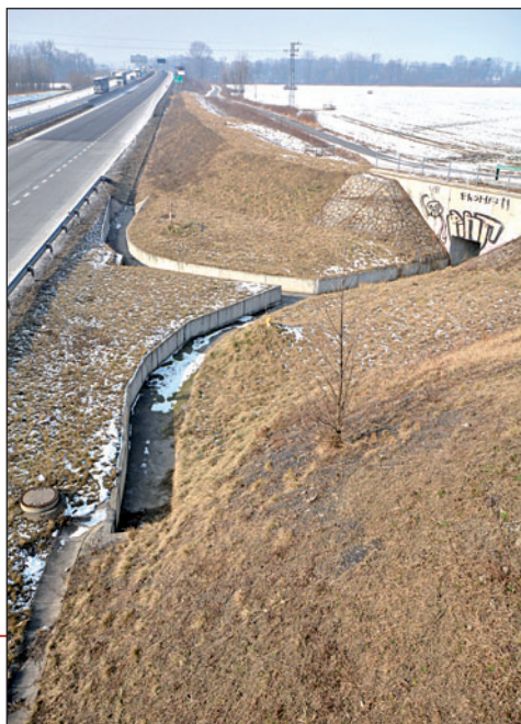
Z podnětu Bohumína a Povodí Odry se připravuje zvýšení valů podél dálnice před vjezdem do Starého Bohumína. Foto: Pavel Čempěl
