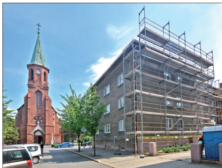
Probíhající oprava domu, do kterého se vstupuje z malého dvorku v Kostelní ulici. V něm už po dokončení nebudou parkovat auta. Foto: Pavel Čempěl
