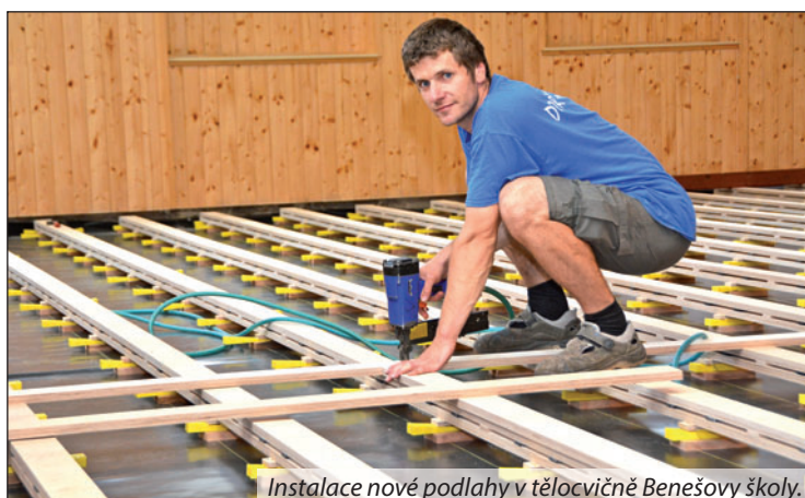
Instalace nové podlahy v tělocvičně Benešovy školy.
