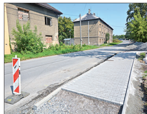
V Drátovské ulici v Pudlově vyrůstá nový chodník, vybydlený dům v pozadí pro změnu zmizí. Foto: Pavel Čempěl
