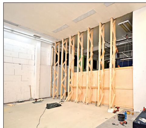
Největší prostor objektu nově odděluje příčka. V jedné části zůstanou badmintonová hřiště, ve druhé vznikne lezecká stěna. Foto: Pavel Čempěl
