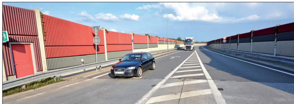
Během měsíční opravy bude provoz v ulici Za Věží sveden do levého pruhu. Na pravé straně proběhne výměna popraskaných soklů. Foto: Pavel Čempěl
