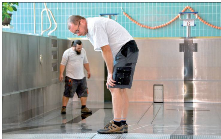
Specializovaná firma prověřila všechny spoje bazénových van, dva spoje pro jistotu znovu svařila. Foto: Pavel Čempěl
