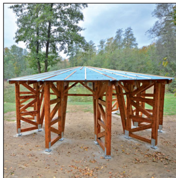
U jednoho z rybníků v Gliňoči v těchto dnech finišuje stavba nové pergoly.
