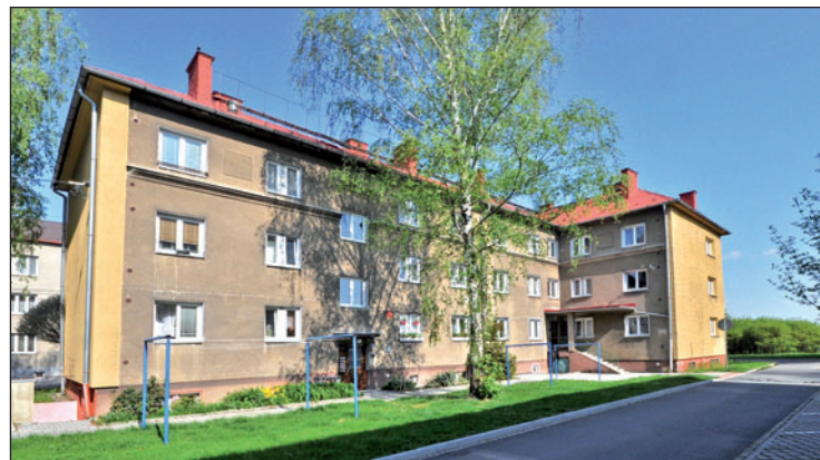
V tomto domě v Nerudově ul. 366 se 28.11. licituje byt 1+2 v 1. nadzemní podlaží. Cihlový dům stojí v nízké zástavbě a byt má zděné jádro.
