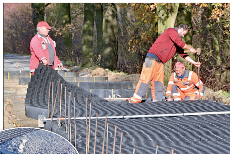
Podloží tvoří plastový komorový systém. Ten má nebývalou nosnost a zpevní základy stezky.
