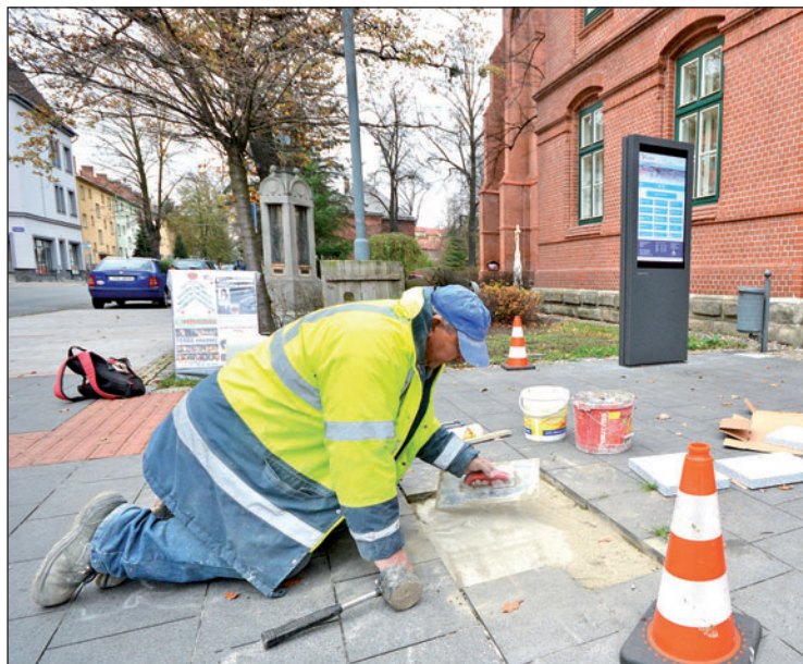
Po demontáži staré úřední desky bylo třeba zacelit otvor v dlažbě. V pozadí už září panel nový a digitální.
