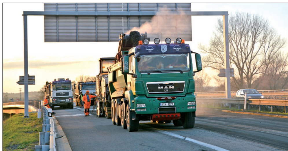
Provizorní oprava magistrály začala v půli listopadu u Bohumína. Rekonstrukce se týká úseku v okolí mostu přes Odru. Motoristé tady musí počítat s omezením a svedením provozu do jednoho pruhu.
