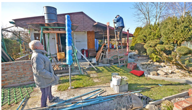
Zdeňka Dominiková s partnerem vyklízejí pozemek ve zrušené osadě v ulici Petra Cingra. Zahrádkářství ale vale nedají, začnou znovu na jiném místě.
