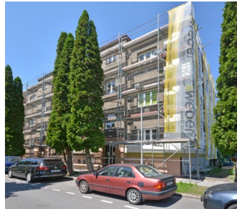
Rekonstrukce domu v Janáčkově ulici bude stát 13,5 milionu a s dokončením se počítá v listopadu.
