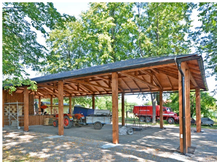
Předloni nahradil popraskanou betonovou plochu v zahradě asfalt. Loni došlo na rekonstrukci pánských toalet, letos to byly současně s altánem a pódium ty dámské.
