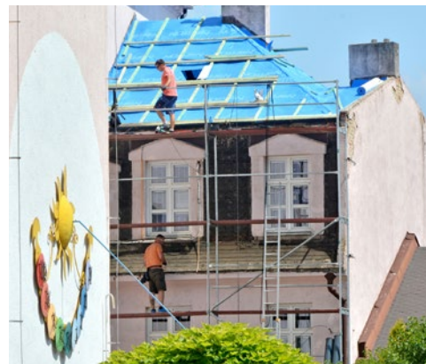
Střecha Benešovy školy dostala novou střešní krytinu.
