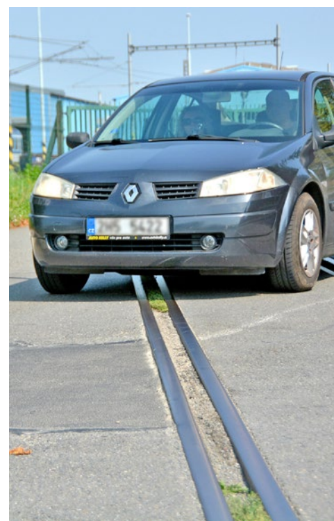
Sjízdnost přejezdu u lávky zajistila firma asfaltovými záplatami.
