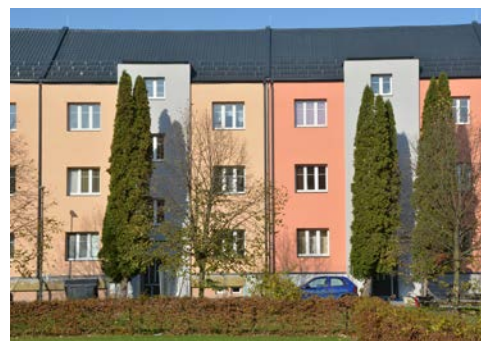
Barevné řešení fasády v Janáčkově ulici od sebe odliší jednotlivé vchody.
