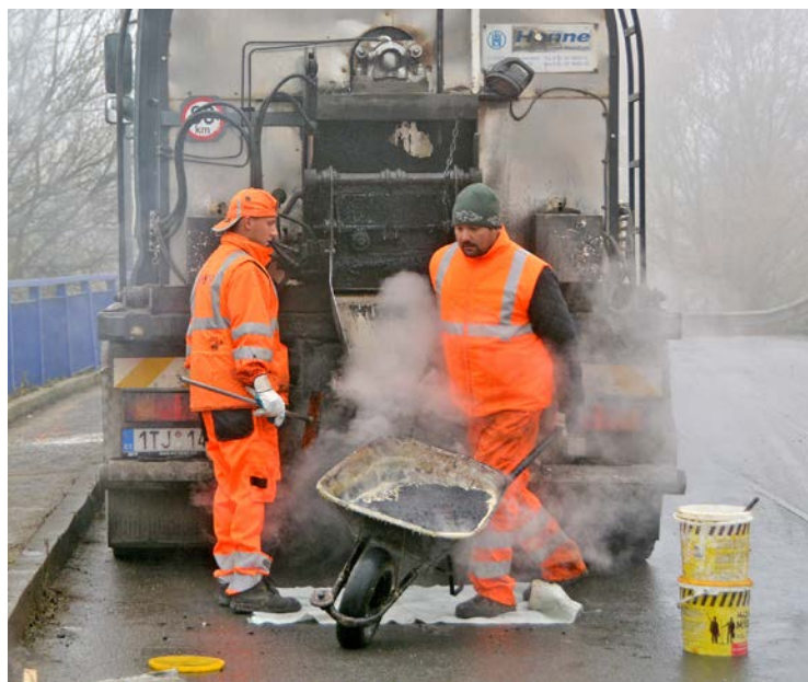
Listopadová obnova chodníku na drátovenském mostě.
