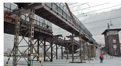
Počátkem roku 2010 šel k zemi ocelový skřečochský most. Ten vyrostl v 50. letech 20. století, kdy nahradil dřevěný most z roku 1887.
