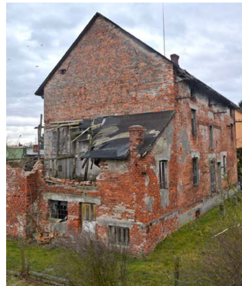
Dny bývalého mlýna v Šunychlu jsou sečteny, připravuje se jeho demolice.
