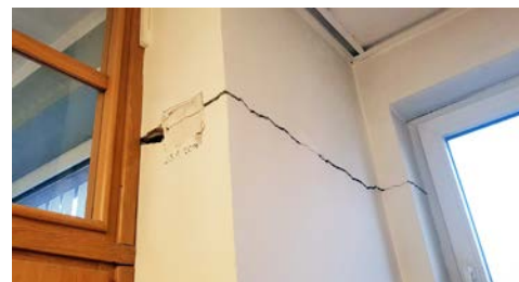
Kvůli anomálii v podloží upadly základy části přístavby a zdi začaly praskat.
