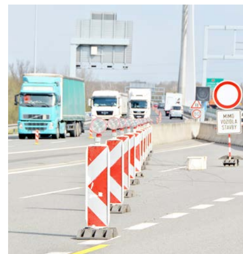
Na dálnice mezi Antošovickými a Vrbicí musí řidiči počítat s omezením. Probíhá oprava dálničního mostu.
