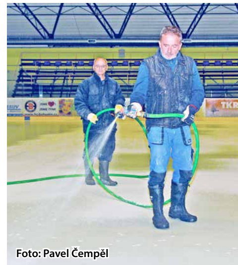
Po dokončení ledové plochy ji pak stačí v sezoně udržovat v automatickém režimu. Standardně má minus 7,5 stupně, při hokejových zápasech minus 8.
